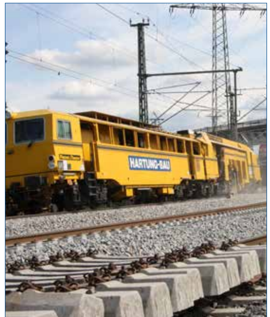
Ausbaustrecke, Nürnberg - Fürth
